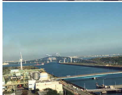
(写真上)新国立競技場建設予定地の視察。これまでの開催都市の事例を見ても、大会後の利用は大きな課題の一つだ (写真下)東京湾の中心で建設中の「海の森公園」の視察
